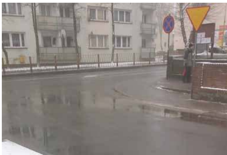
Jeszcze kilka tygodni temu w tym miejscu było widoczne przejście. Dziś go już nie widać
