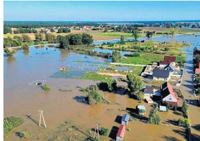
Wrzesień 2024 roku. Powódź zniszczyła głogowskie osiedle Krzepów
