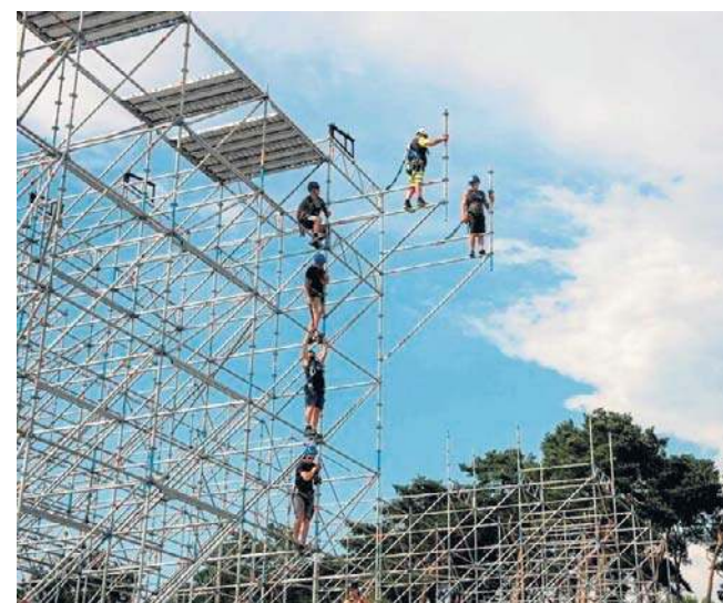
Ekipy sprawnie rozstawiają metalowe konstrukcje na terenie ośrodka
