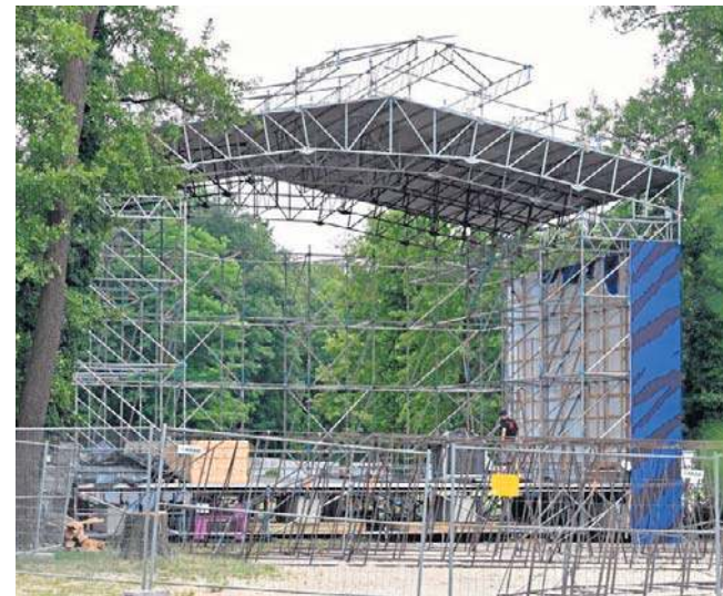
W ostatnich dniach trwało instalowanie scen, na których pojawią się wykonawcy
