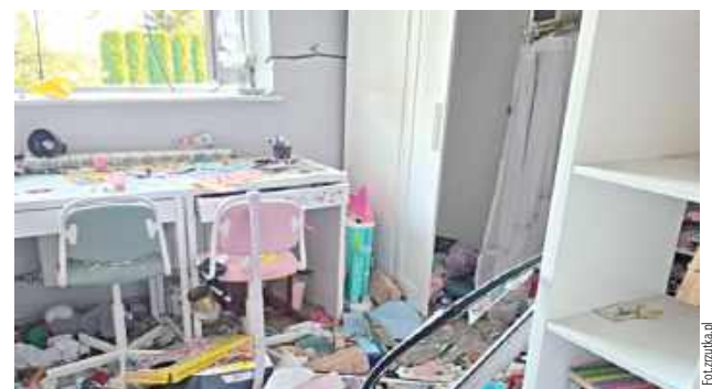
Ze wstępnych ustaleń wynika, że w budynku doszło do wybuchu ulatniającego się z butli gazu
