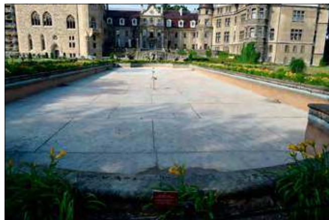
Elementy fontanny zostaną gruntownie wyczyszczone, a w wielu miejscach odtworzone na nowo.
