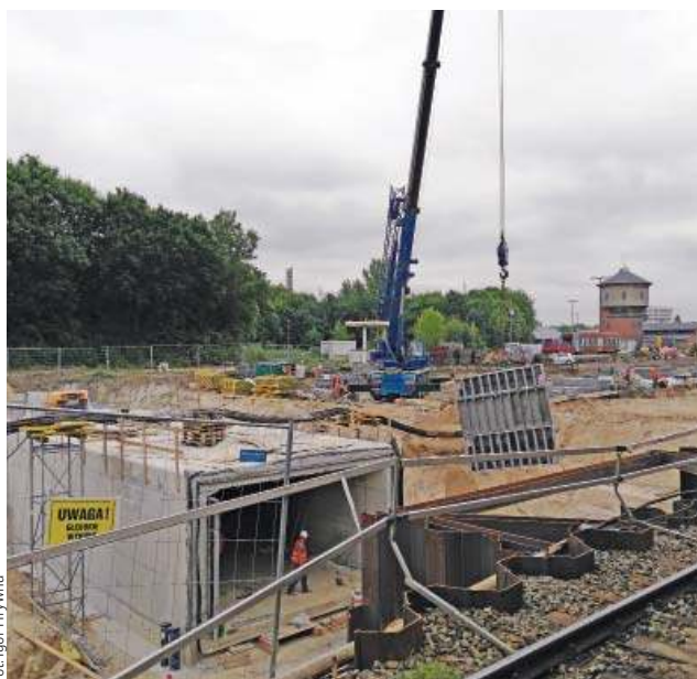
Na dworcu widać już fragmentu tunelu
