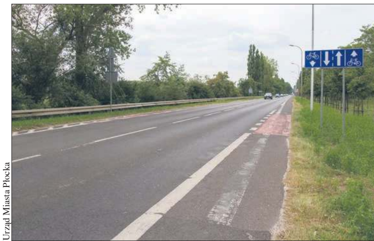
Trwa remont ostatniego fragmentu ul. Kolejowej
