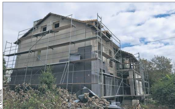
Trwa remont budynku przy ul. Warszawskiej 5
