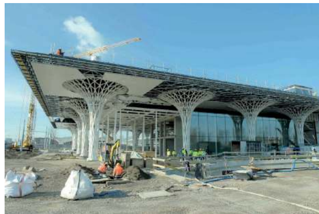
Postępy prac w budowie dworca
