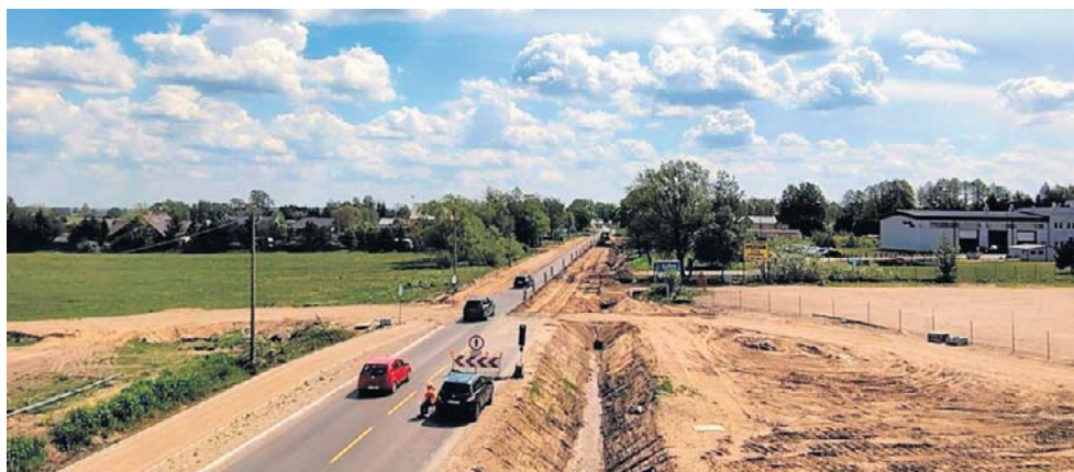
Ruch wahadłowy w godz. 6-18 sterowany jest ręcznie, a w pozostałych godzinach oraz w weekendy – za pomocą sygnalizacji świetlnej
