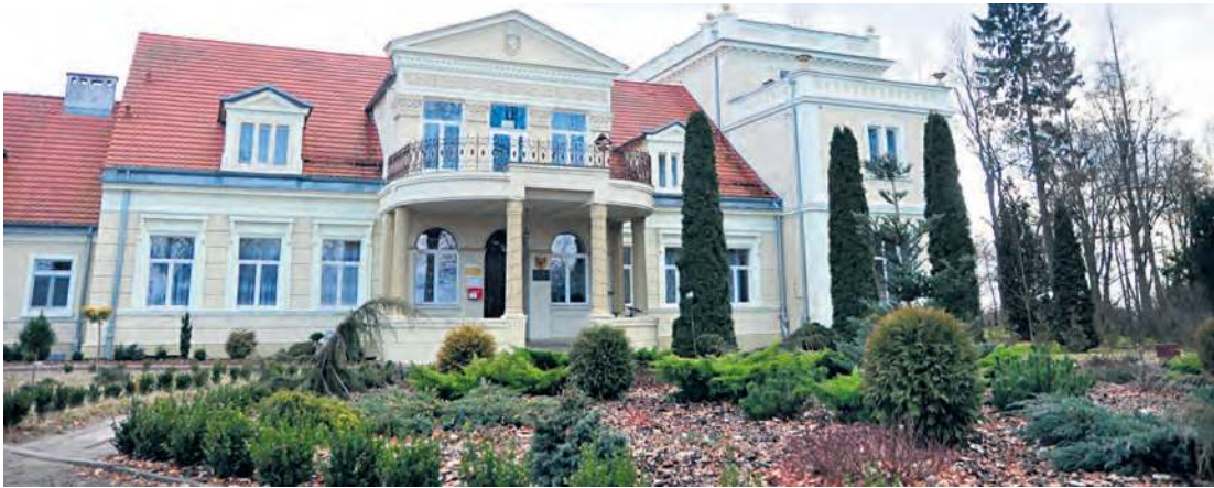
Jeden milion bez grosza trafi na prace przy budynku Domu Pomocy Społecznej w Wysokiej. Po środki te zgłosił się Powiat Tucholski. Fot. (pp)
