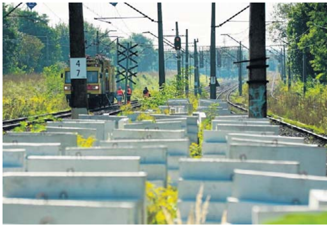
Przejazd odcinkiem Olszamowice - Pilichowice odbywał się wahadłowo
