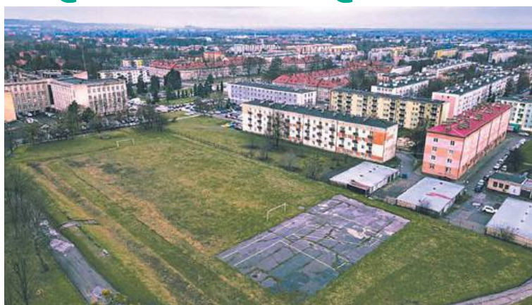
W miejscu starego boiska Budowlanki powstanie stadion ze sztuczną nawierzchnią (fot. Jakub Banaszek / Facebook)
