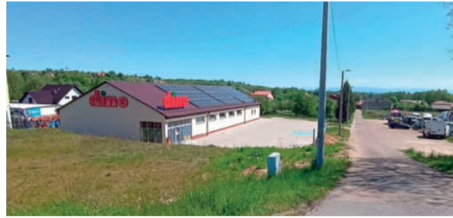
Budynek przy Tęczowej w Libiążu, w którym ma być sklep Dino
