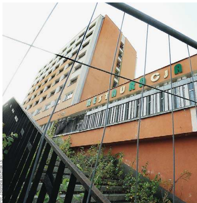
Wczoraj rozpoczęła się rozbiórka hotelu Gromada w pobliżu dworca PKP
