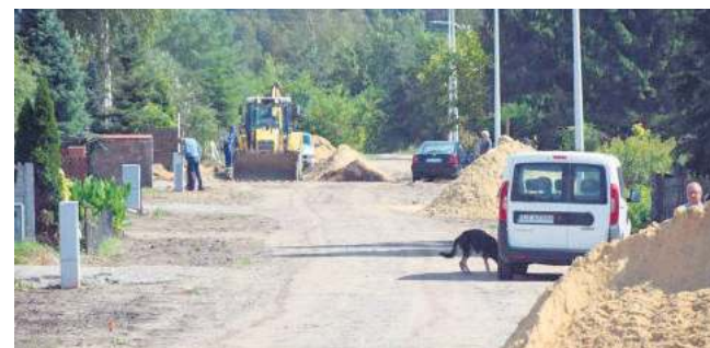
Prace na os. Ogrody trwają.
