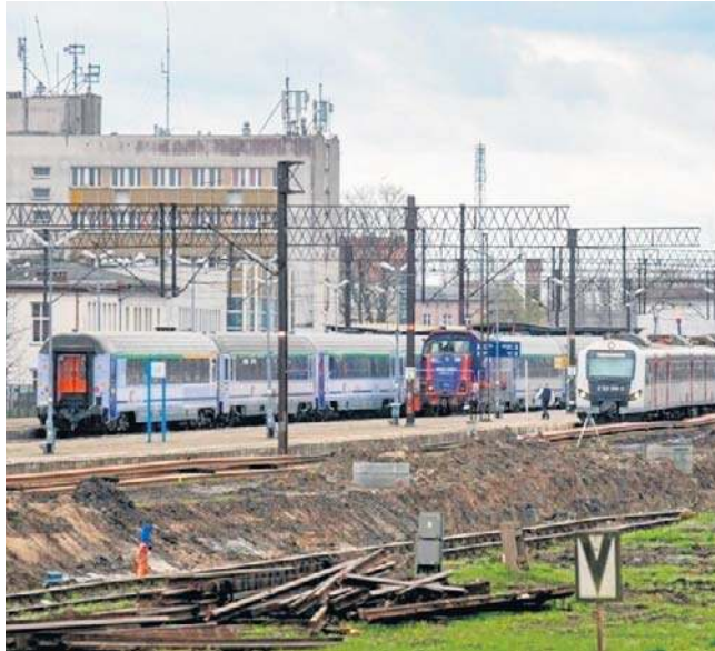
Modernizacja stacji kolejowej w Słupsku oraz linii 202 do Lęborka prowadzone są równocześnie
