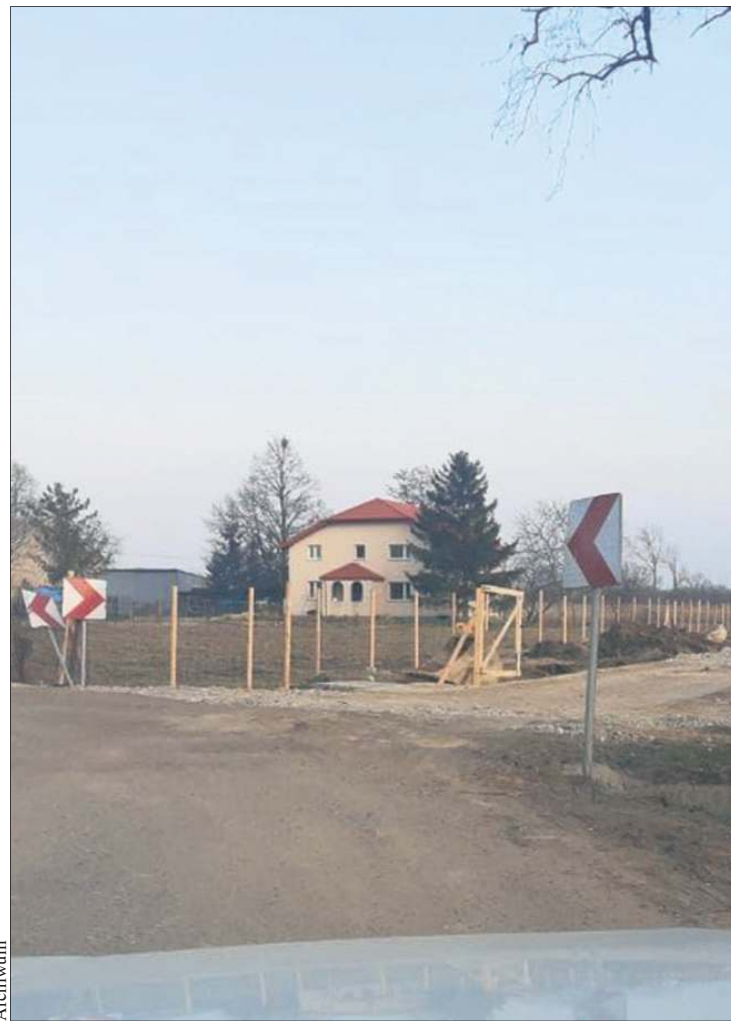
Wyjazd z placu budowy nowej inwestycji powoduje niebezpieczeństwo dla innych pojazdów
