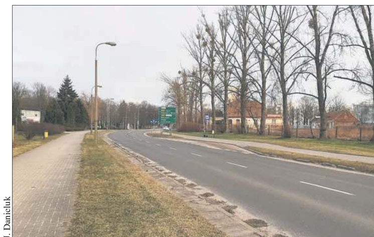
Zwiększenie środków finansowych potrzebnych na remont ul. Łukasiewicza pozwoli na realizację inwestycji
