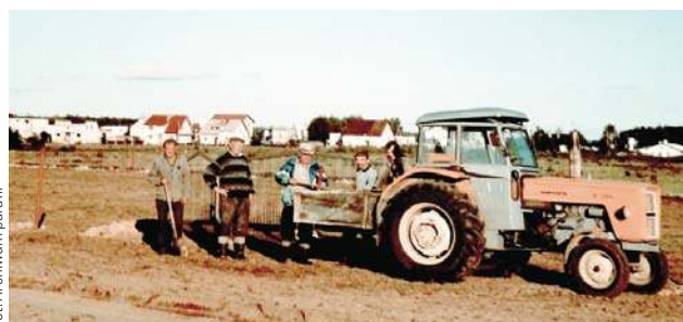
Chwile przed rozpoczęciem budowy kościoła w Jamielniku
