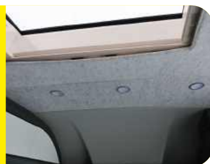
Tekstylna okładzina ładnie wygląda, ale sposób jej montażu pozostawia nieco do życzenia
