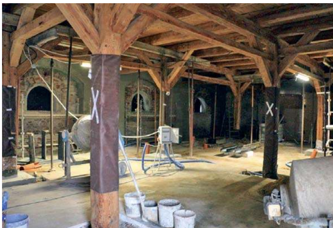
Nadchodzące prace są związane z oczyszczaniem ścian wewnętrznych przy użyciu metody pudrowania (fot. UM Nowa Sól)
