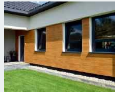
Okładzina realistycznie imituje deski elewacyjne, pomalowano ją zabarwioną bejcą (złoty dąb).
