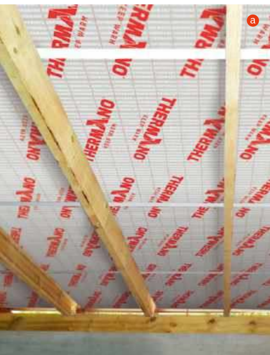
📌 Izolacja nakrokwiowa sprawdza się w budynkach nowych (a) i modernizowanych (b). BALEX METAL
