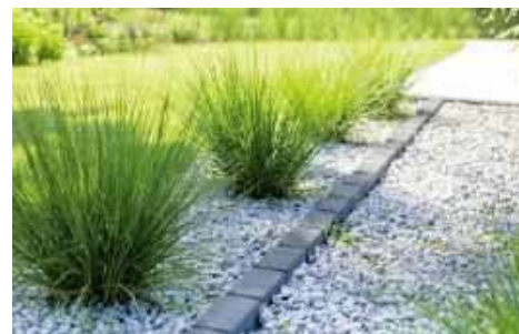
✂ Obrzeża nawierzchni można wykonać z kostek brzegowych lub grubszego bruku. POLBRUK, VESTONE
