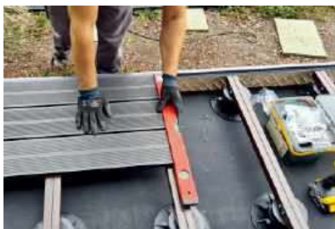
Deski, bez względu na to czy są wykonane z drewna czy z kompozytu, zawsze układa się na legarach z niewielkim spadkiem w stronę ogrodu. RENOPLAST
