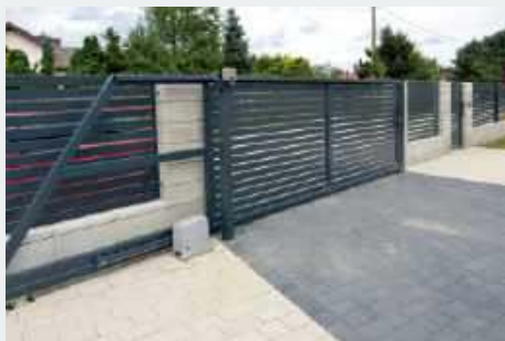
➤ Przesuwną jednoskrzydłową bramę (5 m) uruchamia napęd elektryczny.
