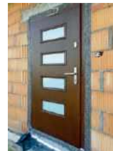
📌 Drzwi osadzone prawidłowo, zabezpieczone taśmą paroszczelną i paroprzepuszczalną. M. MARCHEWKA
