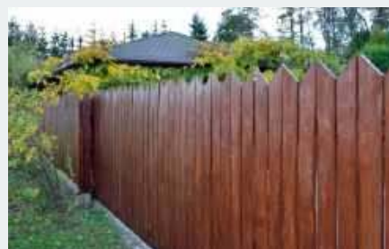
🔗 Sztachety przytwierdzono wkrętami do poprzeczek z drewna modrzewia, do stalowej ramy w bramie wjazdowej – śrubami.
