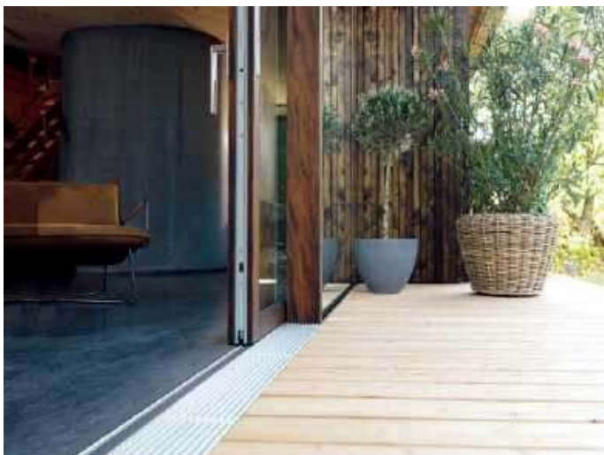
🔑 Zastosowanie niskiego progu w przesuwnych drzwiach tarasowych ogranicza ryzyko potknięcia podczas wychodzenia na taras. SIEGENIA
