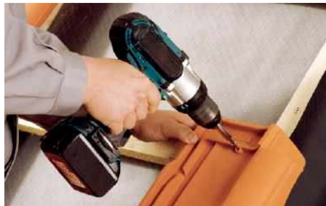
Montaż dachówki bocznej. CREATON POLSKA
