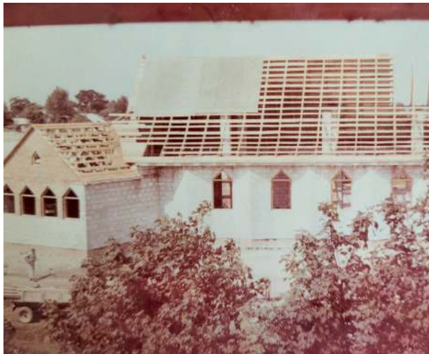
Prace budowlane rozpoczęły się w marcu 1983 r.
