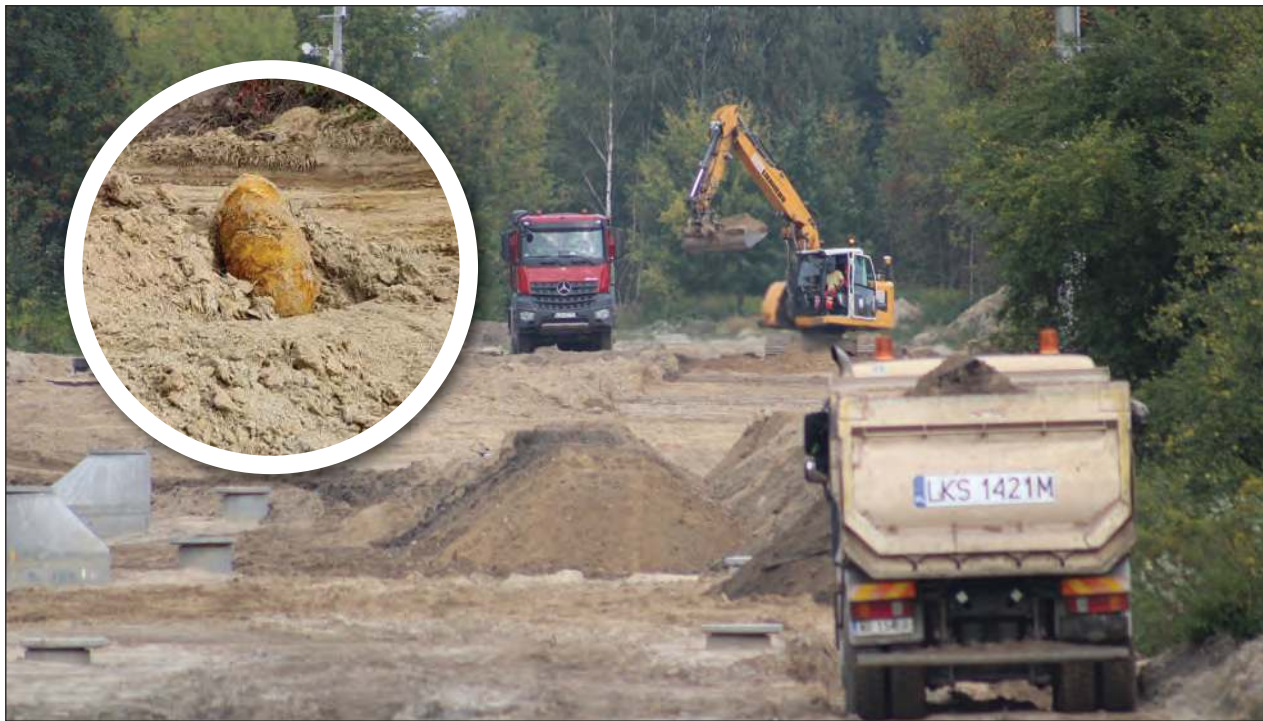
Na dęblińskim osiedlu Wiślana-Żwica o mały włos nie doszło do tragedii. W poniedziałek rano robotnicy pracujący przy budowie obwodnicy miasta natknęli się na bombę z czasów II wojny światowej
