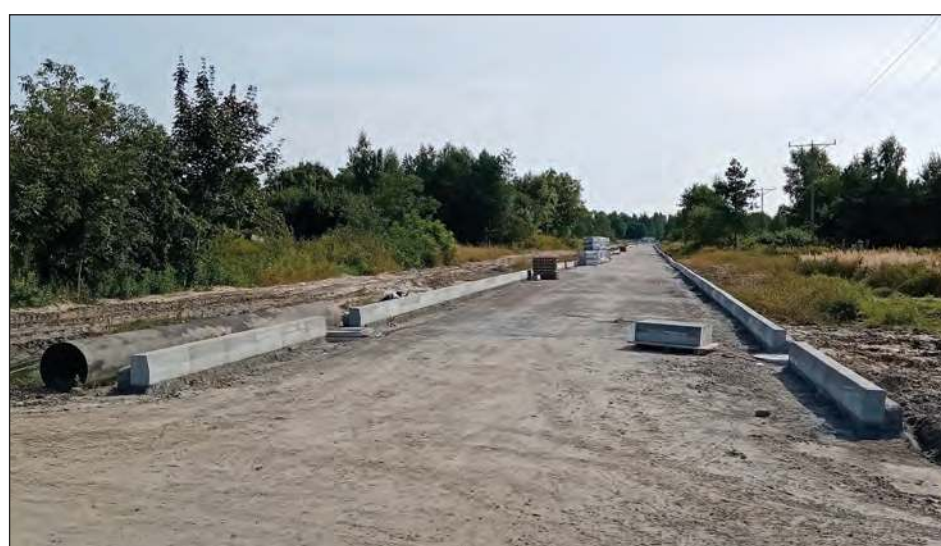
✚ Od ul. Okrzei w kierunku Wiślanej zamontowane zostały już krawężniki. Nawierzchnia jest przygotowana pod wylanie mieszanki asfaltowej. Podobna sytuacja występuje w kierunku ul. Kościuszki
