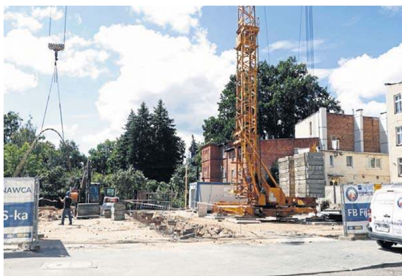
Budowę nowej sali koncertowej Państwowej Szkoły Muzycznej prowadzi Firma Budowlana Fijałkowski i S-Ka z Torunia
