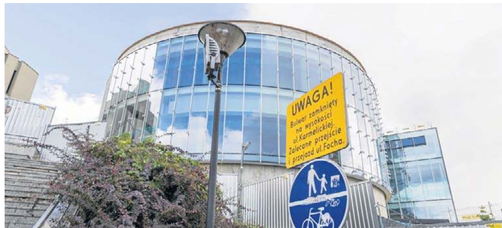
Umowę podpisano w styczniu 2023 r. Za realizację inwestycji odpowiada firma Budimex. Ostateczny koszt budowy IV kręgu ma zamknąć się w okolicach 190 mln zł
