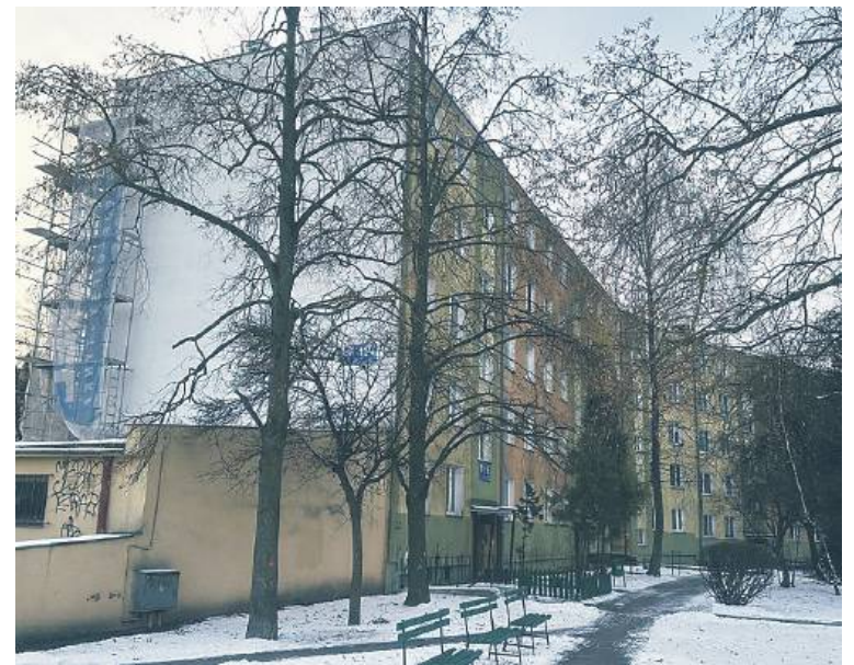
Jedną z największych w 2025 roku inwestycji ChSM, była rozpoczęta termomodernizacja bloku przy Al. Żołnierzy I AWP 19 na osiedlu XXX-lecia
