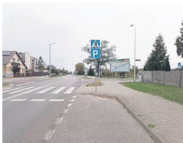
Parkingi zlokalizowane w sąsiedztwie ulic bocznych są kłopotliwe. Kierowcy włączający się do ruchu mają problem z widocznością.
