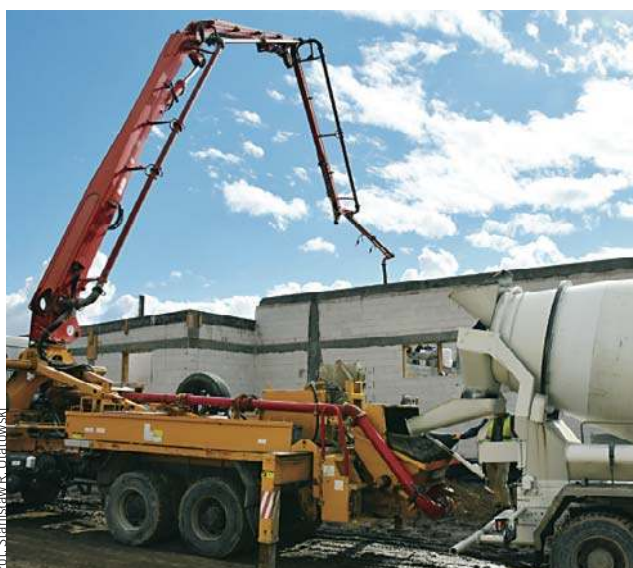
Budowa stacji uzdatniania wody w Nowym Mieście Lubawskim
