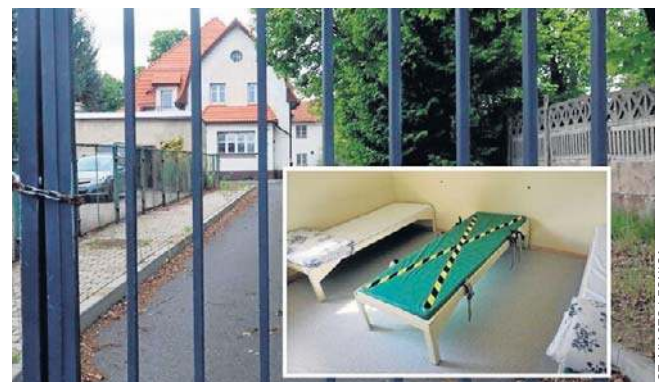
Tak budynek izby wytrzeźwień wyglądał kilka lat temu
