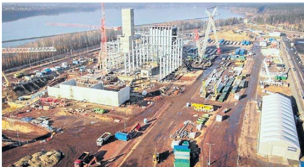
W 2026 roku planowane są pierwsze rozruchy próbne nowej instalacji, a zakończenie prac przewidziano na pierwszy kwartał 2027 roku
