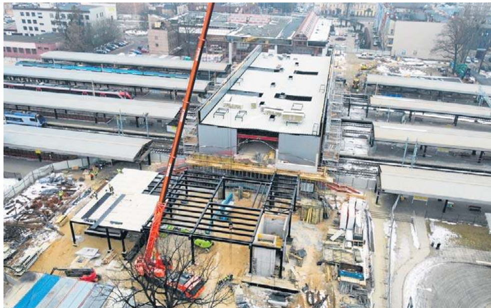
Przebudowa dworca PKP w Częstochowie. Trwa montaż metalowych paneli elewacji nad łącznikiem scalającym wschodnią i zachodnią część obiektu
