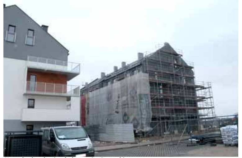
Nowy budynek mieszkalny na Os. Pyrzyckim
