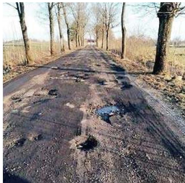
Odcinek drogi Prosimy - Księżno, gmina Bisztynek powiat bartoszycki
