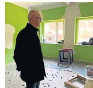
Trwa modernizacja świetlicy wiejskiej w Dąbrowie w gminie Kuślin
