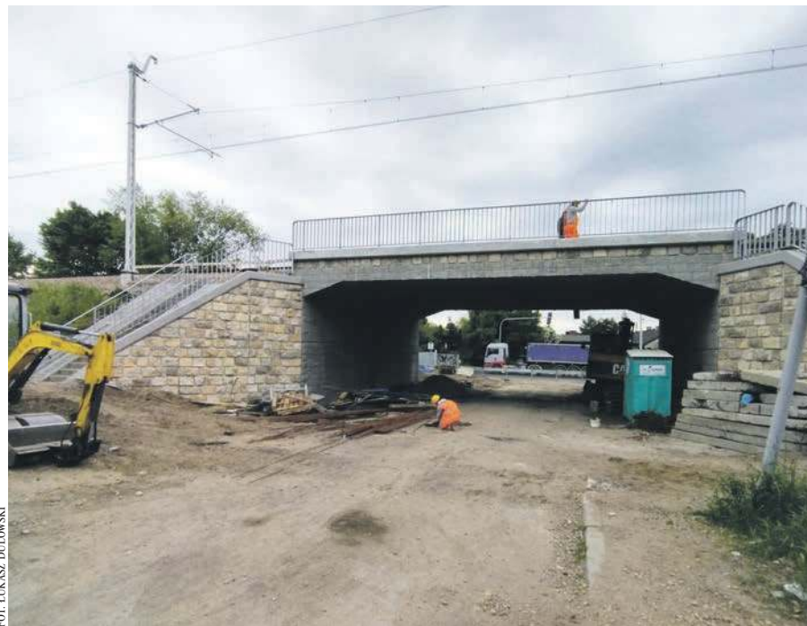
(MK) Wiadukt nad ul. Kadłubek w Chrzanowie
