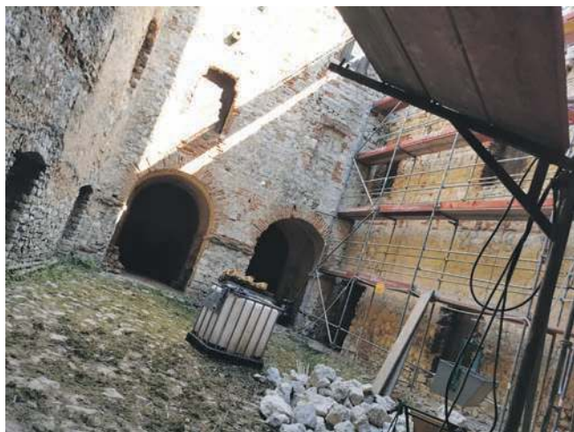
Prace trwają m.in. na dziedzińcu
