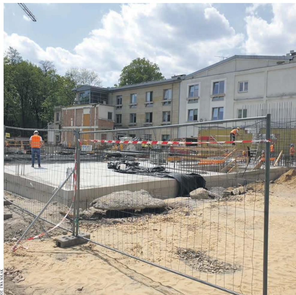
Prace budowlane przy balneologii idą pełną parą
