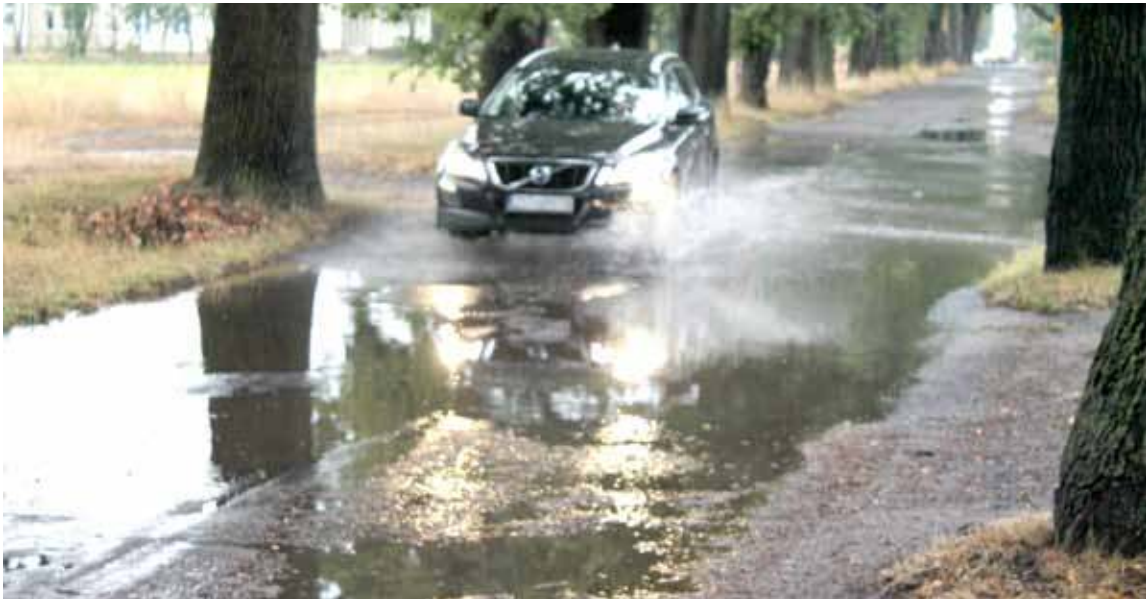
Jak widać na zdjęciu na ulicy Niemcewicza jazda samochodem przypomina rajd. UM zapowiada odwodnienie drogi i miejscowe łatanie dziur. Kierowcy trzymają za słowo
