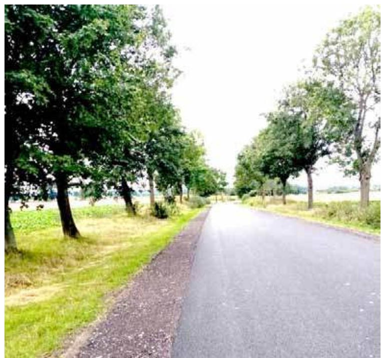
W ramach przebudowy drogi prowadzącej do Żukowa wymieniona została nawierzchnia jezdni i wykonane zostały umocnienia pobocza
