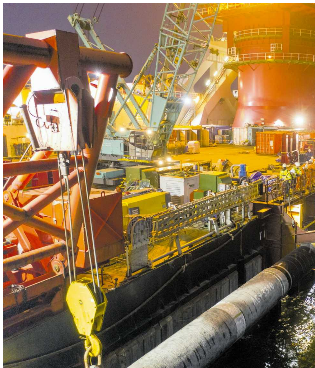
• Prace przy fragmencie bałtyckiego gazociągu Nord Stream 2 FOT. NORD STREAM 2
