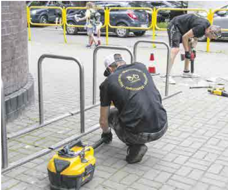
Montaż stojaków przebiega bardzo szybko
