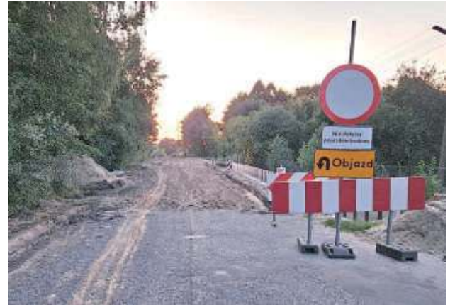
Od strony Rudnik aż do mostu został już zerwany asfalt
