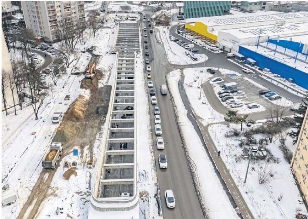
Trwa budowa linii tramwajowej z ul. Meissnera do Mistrzejowic
