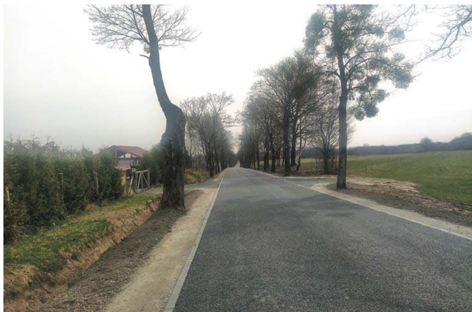
W kwietniu tego roku zakończyła się również przebudowa drogi powiatowej Zastawno – Kwietnik II Etap o długości 1,63 km
