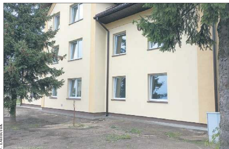
Blok przy ul. Miodowej 27 jest już gotowy
