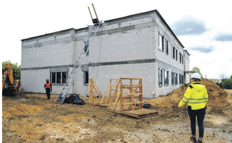
Dom będzie gotowy jeszcze w tym roku
