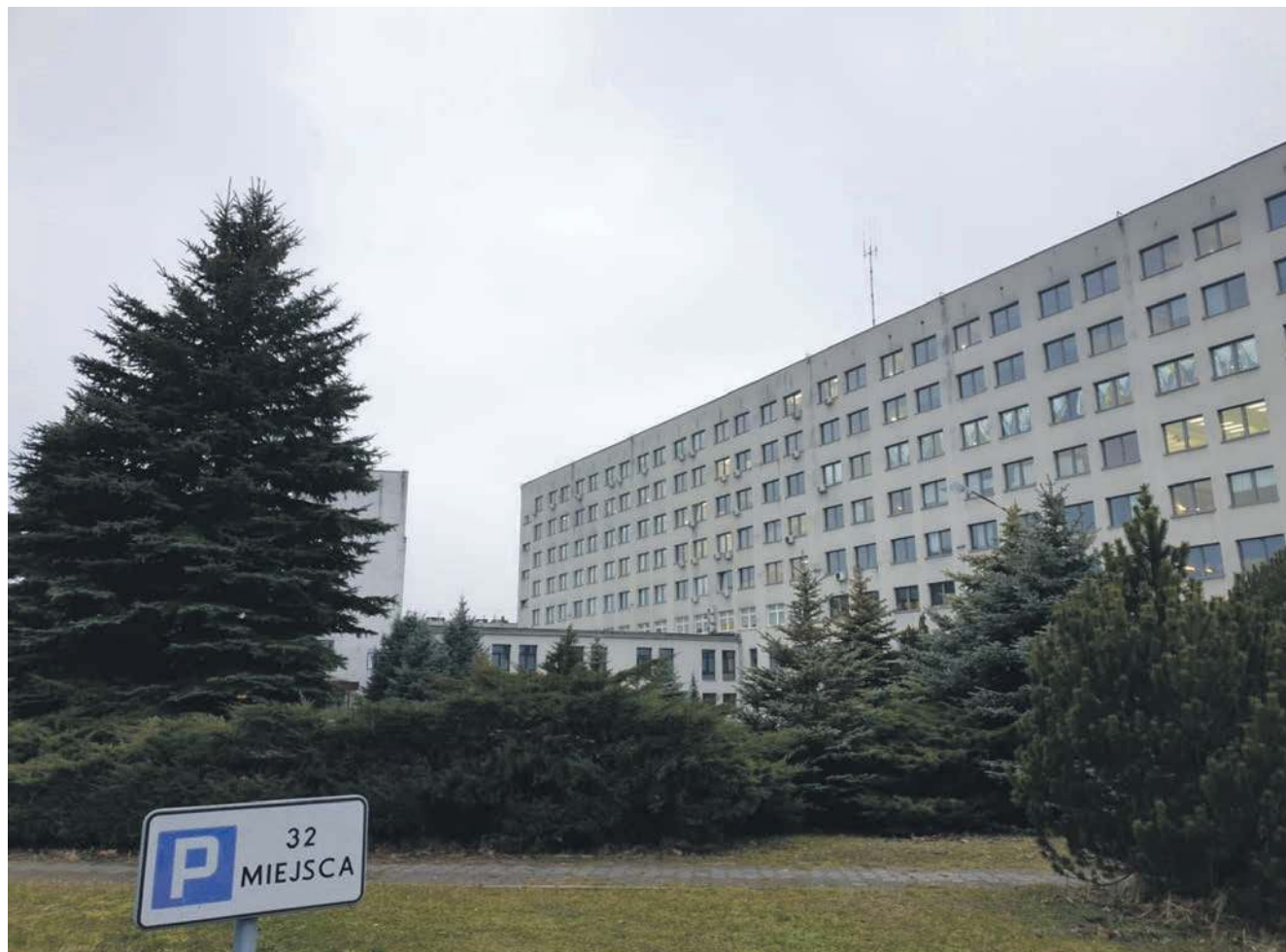
Do budynku szpitala ma zostać dobudowane dodatkowe skrzydło, gdzie zacznie działać zakład opiekuńczo-leczniczy
