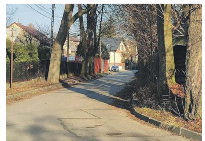
(zew) Będzie remontowana m.in. Starowiejska w Trzebini
