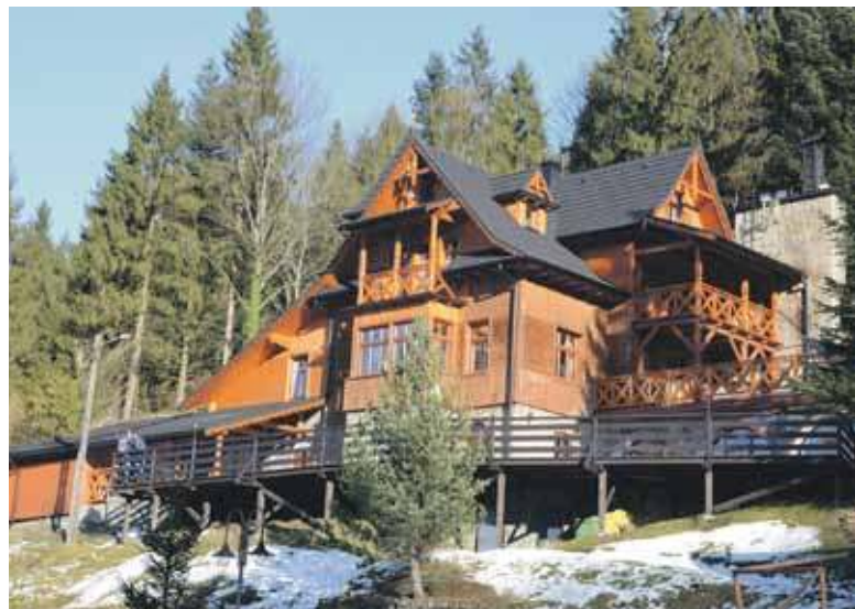
Schronisko "Orlica" kilka lat temu przeszło generalny remont.
