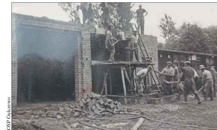
Budowa garażu. Lata 70-te XX wieku
