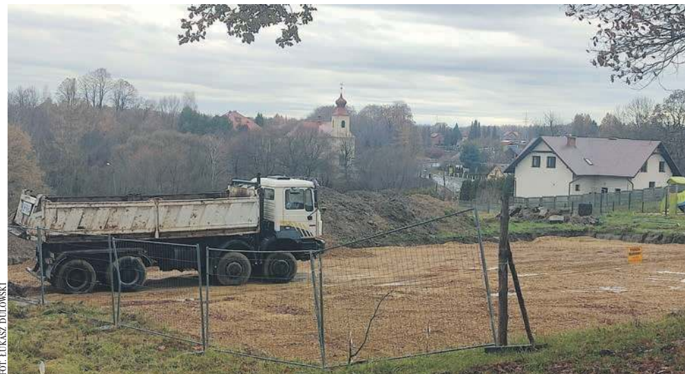
Budowa kompleksu sportowo-rekreacyjnego w Porębie Żegoty
