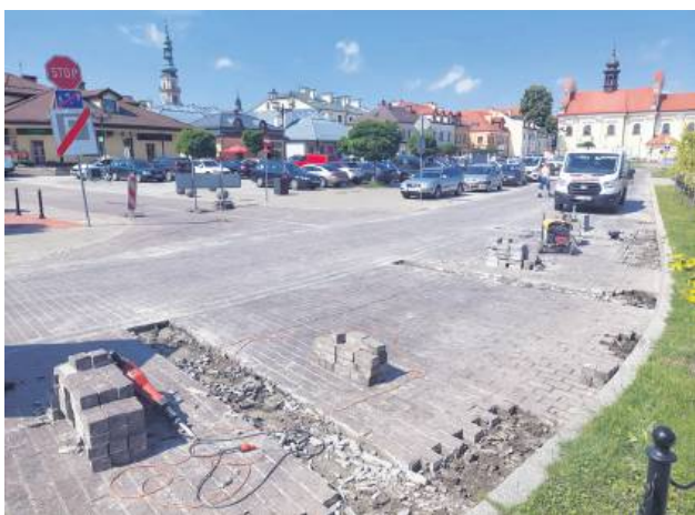
Prace przy ul. Łukasińskiego w Zamościu potrwać do końca wakacji.
