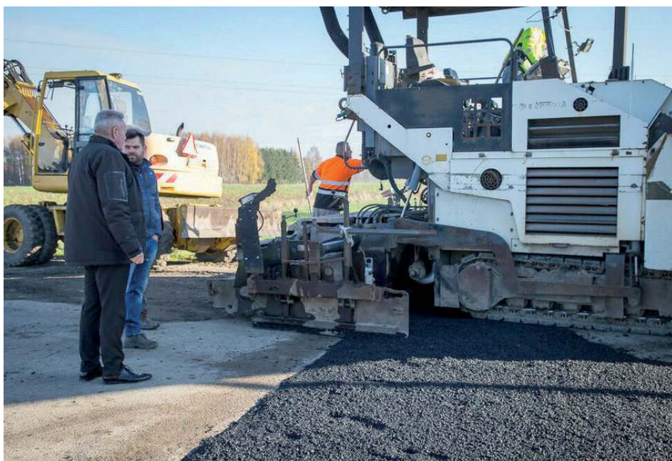
Przebudowa gminnej drogi w miejscowości Pólko
