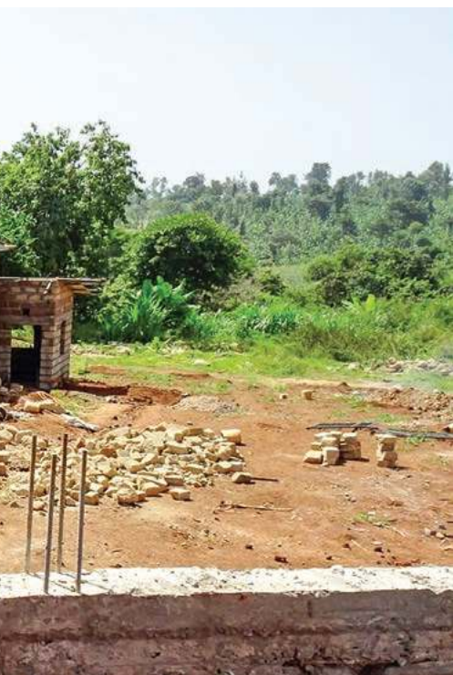
Budowa dormitorium przy szkole Shalom Home w Mitunguu, 25 stycznia 2022 r.
