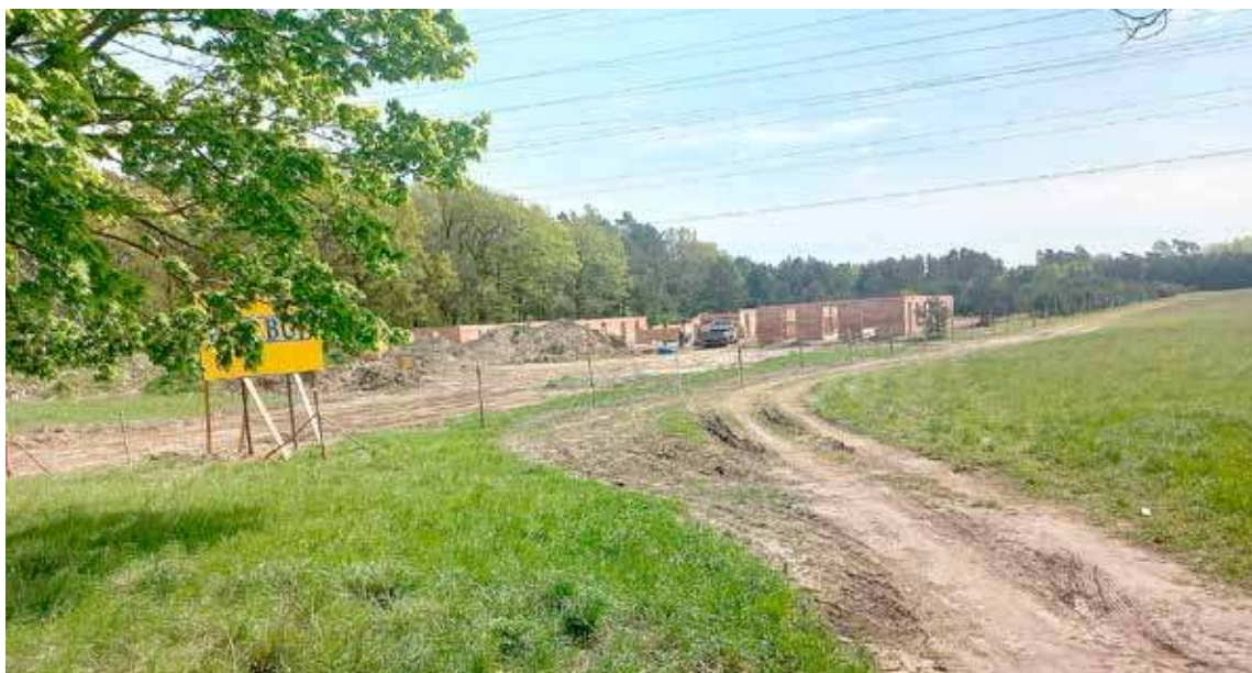
Mury szybko pną się do góry. Zakończenie tego etapu prac budowlanych przewidziane jest za ok. 1,5 tygodnia
