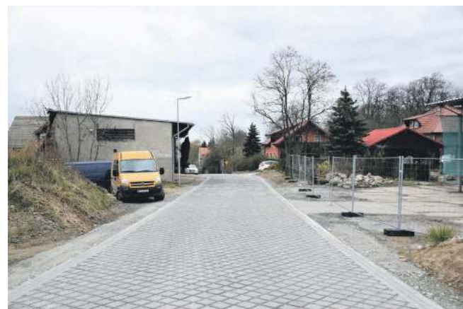
W Wiszni Małej zakończyła się budowa I etapu przebudowy ulicy Polnej
