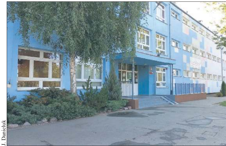
J. Danieluk W budynku Szkoły Podstawowej nr 3 przy ul. Kossobudzkiego ma powstać żłobek
