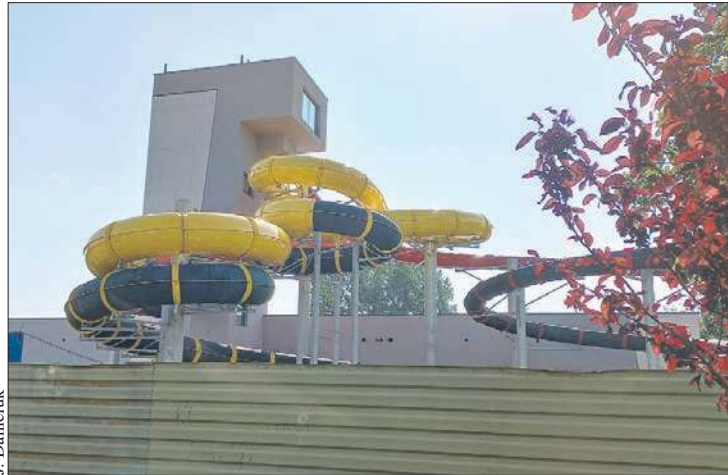
Na budowie aquaparku widać już elementy zjeżdżalni
